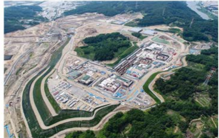
시설건설 시공 현황(18.5)
