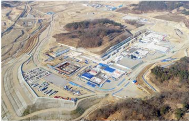
시설건설 시공 현황(17.12)
