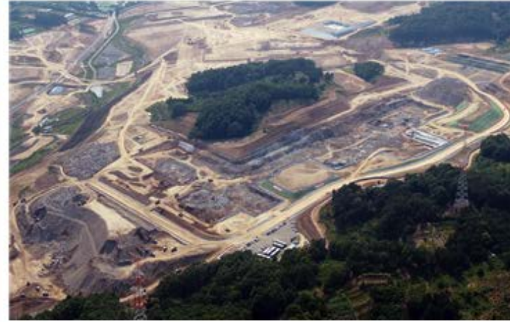
시설건설 시공 현황(17.6)
