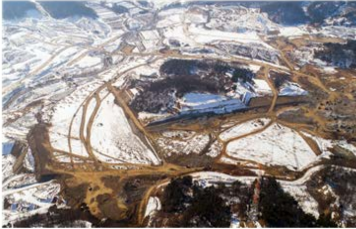
시설건설 시공 현황(17.1)
